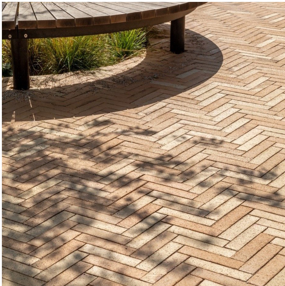
Reference: Nažloutlá cihlová dlažba
