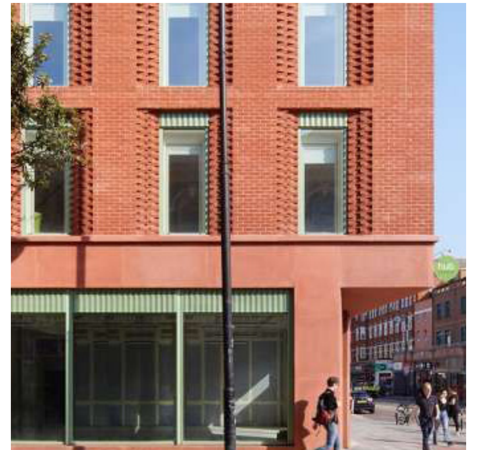
Příklad zdiva na fasádě
